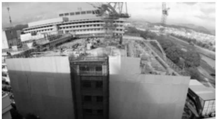
建設工事の様子(11/22撮影)
