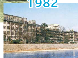
鴨川より基礎1号館及び病舎
