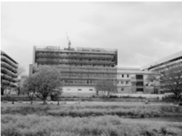
鴨川からみた建設現場の様子
