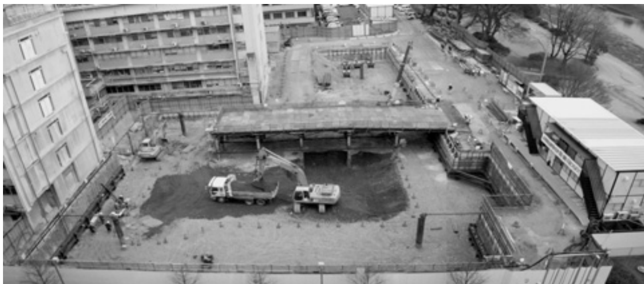
掘削工事の様子
